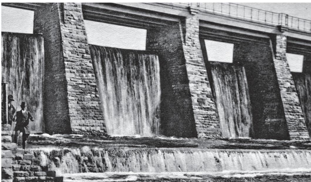
Das Wameler Becken, das als Absetzbecken dient, wird durch den Stockumer Damm auf einen Mindestwasserpegel gehalten. Das wird durch ein Stauwehr zwischen den vier Pfeilern der Brücke in Dammmitte erreicht. Bei Niedrigwasser im Hauptbecken entsteht hier ein Wasserfall. Gut ist auf dem Bild um 1920 zu erkennen, wie schmal damals die Straße war.
