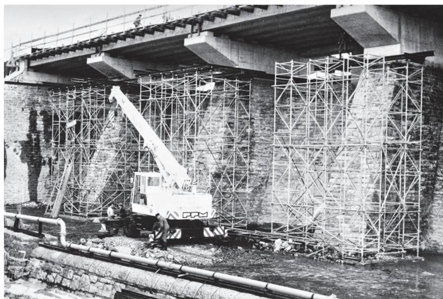
In den Jahren 1982 und 1983 wurde der Stockumer Damm umfangreich saniert und die Landesstraße 857 über ihn verbreitert. Dafür musste der Wasserspiegel des Möhnesees beträchtlich abgesenkt werden, damit die Baumaschinen an seinem Fuß arbeiten konnten. Auf die gemauerten Stützpfiler des Stauwehrs wurden damals breite Betonträger für die neue Straße gesetzt, die auch noch den Bau eines Fuß- und Radwegs ermöglichten.
