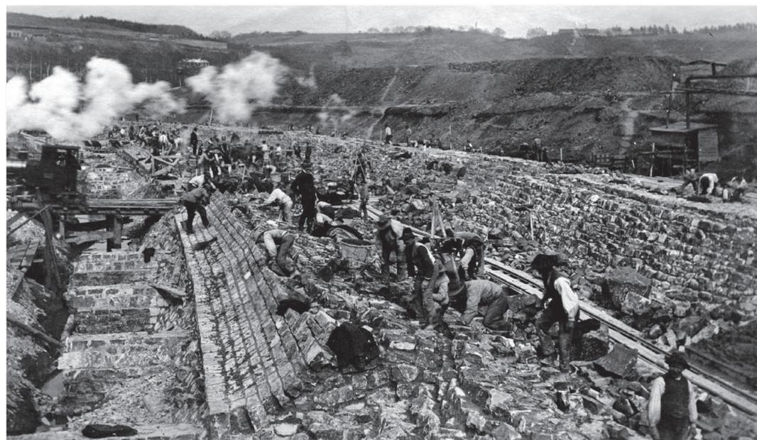
Bis zu acht Meter tief legten die Bauarbeiter das Fundament für den Mauerbau in den Boden. Am Fuß besitzt das Bauwerk eine maximale Breite von 34 Metern. Die Gewichtsstaumauer ist durch und durch aus Bruchsteinen aus Müschede gemauert und an der höchsten Stelle 40 Meter hoch.
