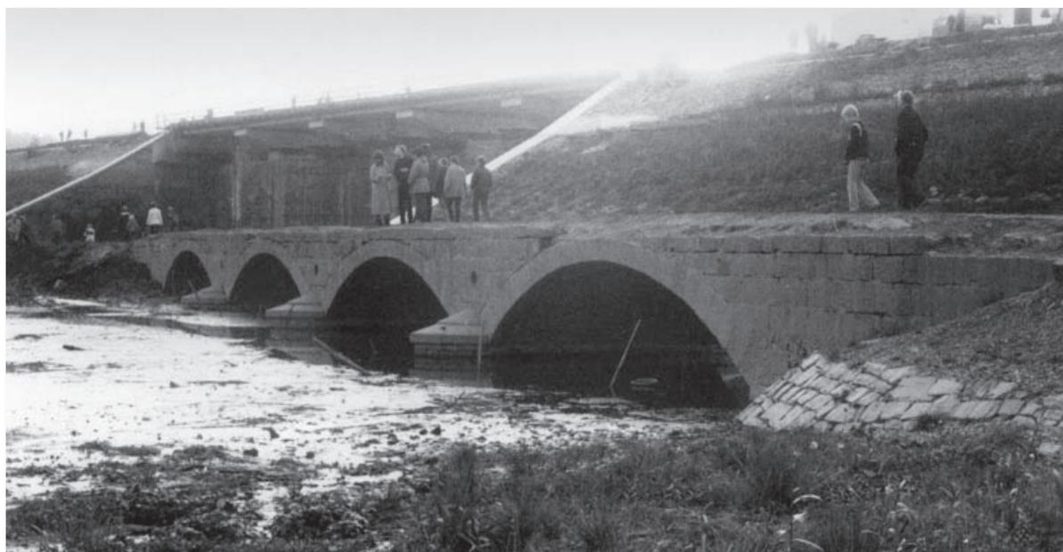
Von Stockum aus querte vor dem Bau des Sees die Neuhäuser Forststraße Richtung Süden das Möhnetal. Beim Aufstau des Sees verschwand die alte Brücke über den Möhnefluss, die nicht abgerissen wurde, in den Fluten. Bei der Sanierung des Stockumer Damms 1982/83 musste das Wameler Becken abgelassen werden. Dadurch kam die alte Brücke wieder zum Vorschein.
