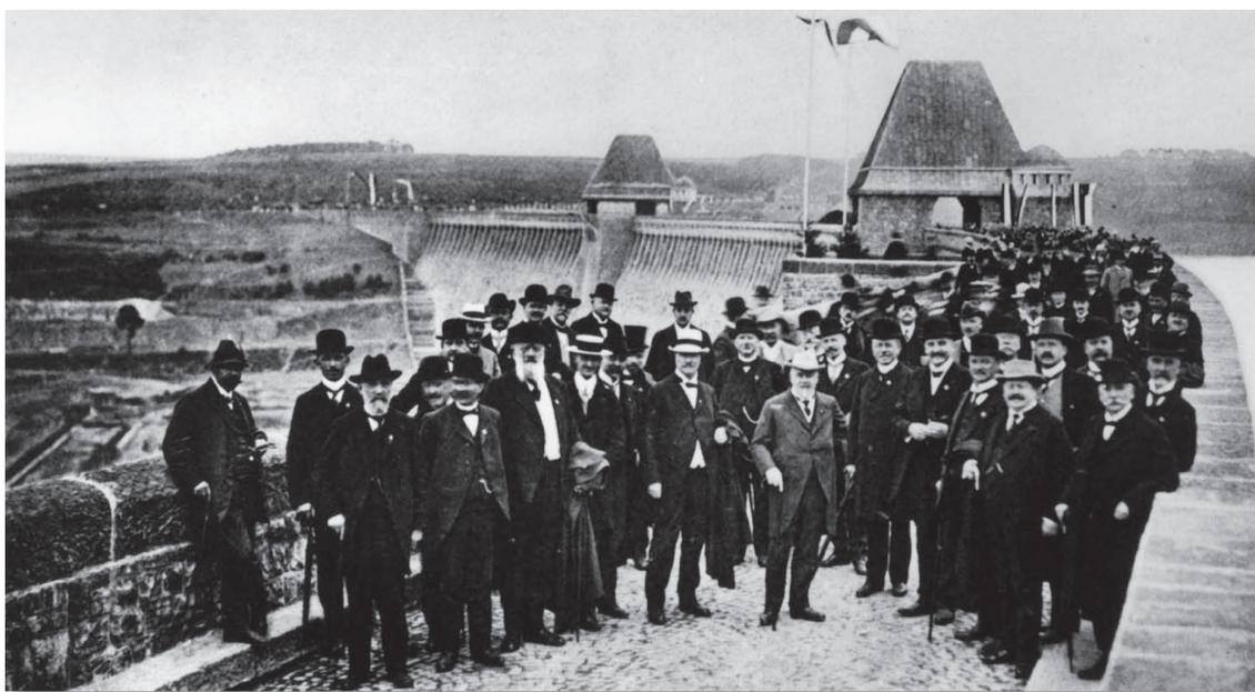
Im Oktober 1912 war der Bau der Sperrmauer abgeschlossen. Während auf der „Seeseite“ rechts der Probestau begann, errichteten Bauarbeiter auf der „Landseite“ mittig unterhalb der Mauer das große Kraftwerk, den Ausgleichsweiher und ein Nebenkraftwerk. Offiziell eingeweiht wurde die Talsperre am 12. Juli 1913, nachdem der See aufgestaut war.
