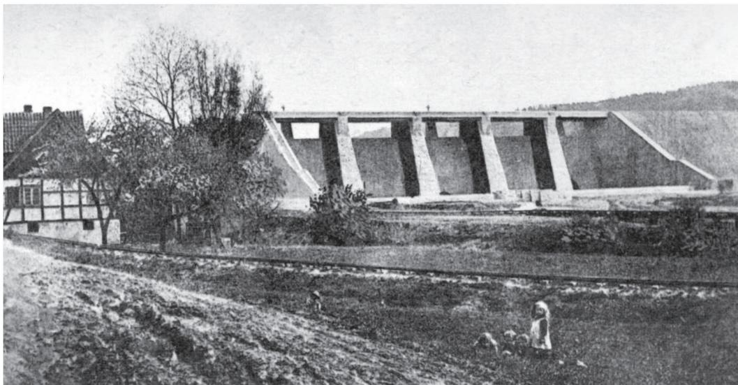
Während des Baus der Talsperre wurde eine Feldbahn eingesetzt für den Materialtransport im Möhnetal. Auf dem Foto aus der Bauphase spielt das kleine Mädchen vor den Gleisen nach Körbecke. Im Hintergrund sieht man die gemauerte Brücke des Stockumer Damms. Der südliche Dammabschnitt ist schon aufgeschüttet, der nördliche fehlt noch. Das Fachwerkhäus wurde später abgerissen.
