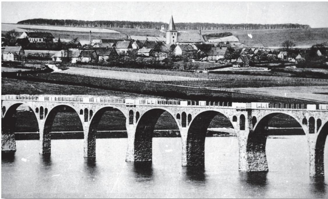
Wie bei den meisten Brücken am Möhnesee errichtete man 1911 bis 1912 die Körbecker Brücke aus Bruchsteinen aus dem Delecker Steinbruch. Für die Bögen konnte man Gerüst und Schalung der früher vollendeten Delecker Brücke verwenden. Zum Missfallen der Körbecker damals baute der Ruhrtalesperrenverein aus Kostengründen die neue Brücke viel weiter westlich als die alte Flussbrücke auf.
