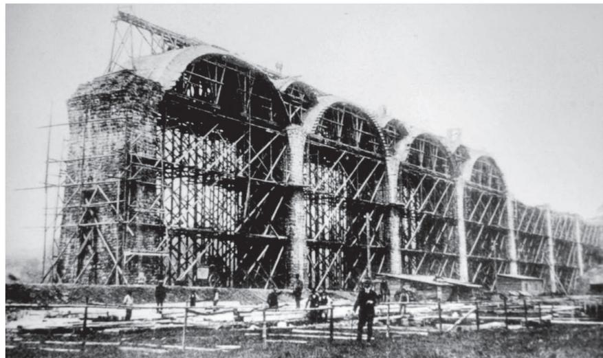
Auf zwölf Pfeilern ruhte die 650 Meter lange und knapp 29 Meter hohe Delecker Brücke, die von 1909 bis 1912 gebaut wurde. Die Pfeiler sind teils aus Delecker Bruchstein gemauert, der gleich neben der Brücke am Südufer aus dem Steinbruch am Mühlenberg stammte. Das aufwändige Holzgerüst konnte beim Bau der Körbecker Brücke wiederverwendet werden.
