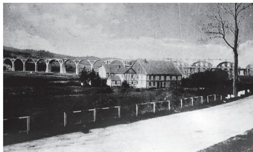
Gegen Ende des Zweiten Weltkriegs sprengte die Wehrmacht die südlichen Bögen der Körbecker Brücke. Diese wurden nach dem Krieg nicht repariert. 1962 wurde die Brückenruine wegen Baufälligkeit gesprengt und durch einen Neubau aus Spannbeton ersetzt, der 1965 fertig war. Am Nordufer war eigens für den Brückenbau ein Werkplatz mit Portalkran eingerichtet worden.
